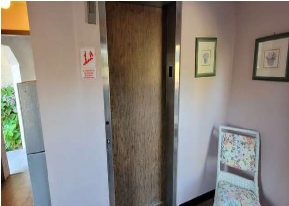
101 Elevator Cab Door
